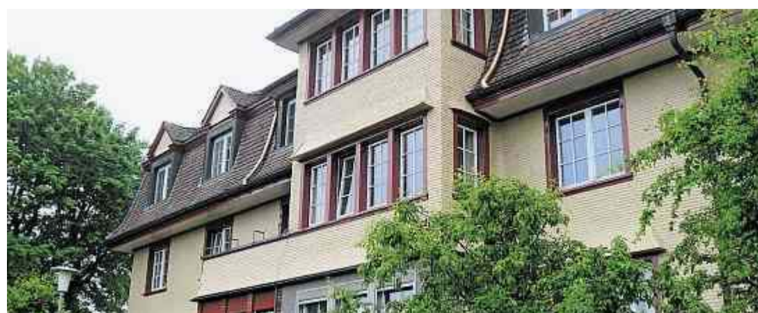
Die Vorderseite der Wohnheim-Liegenschaft zeigt sich nach der Aussensanierung in neuem Glanz.
